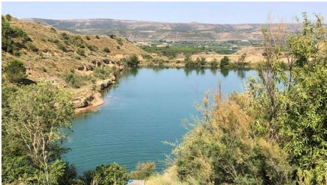
Aqualia se encarga del abastecimiento de agua potable a Zaragoza y sus alrededores.
