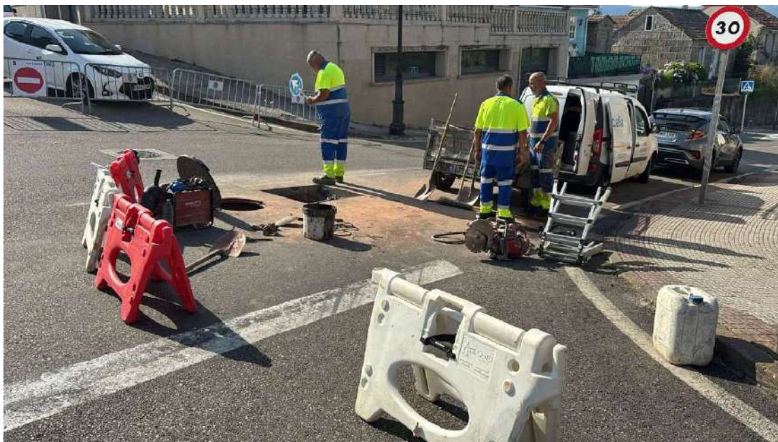
Obras de sellado de la tubería de la fuga de fecales en Nigrán - Ayuntamiento de Nigrán
