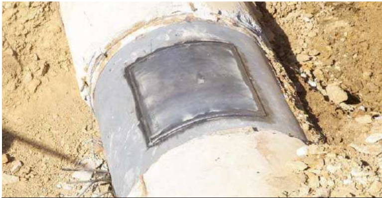
Una tubería reparada en una imagen de archivo.
