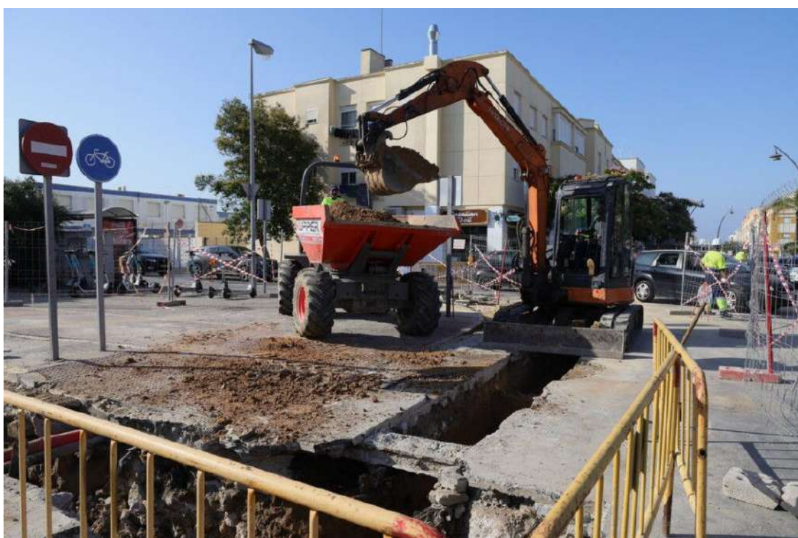
La maquinaria trabaja en la zona cortada al tráfico
